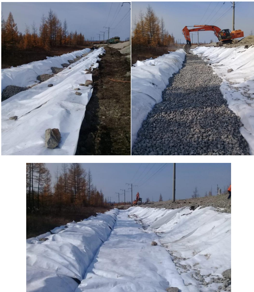
Рис. 6 «Внедрение армодренажной системы в 2019-2020 гг. на перегоне Маревая-Змейка Дальневосточной железной дороге»
